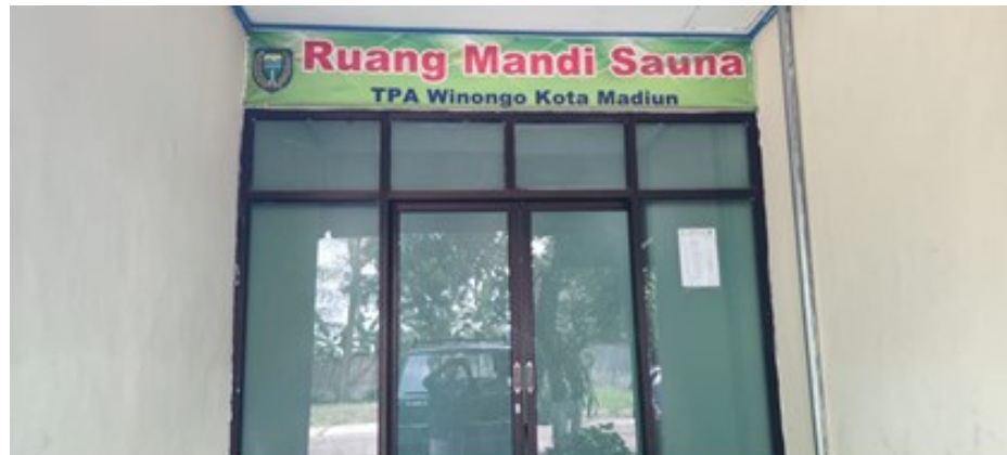
Gambar 4.6. Penggunaan Gas Methan TPA Winongo untuk Proses Mandi Sauna
